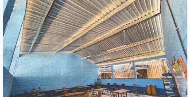
Foto 2: Se observa el estado actual de la estructura de techo, reemplazadas por costaneras nuevas en su totalidad.
