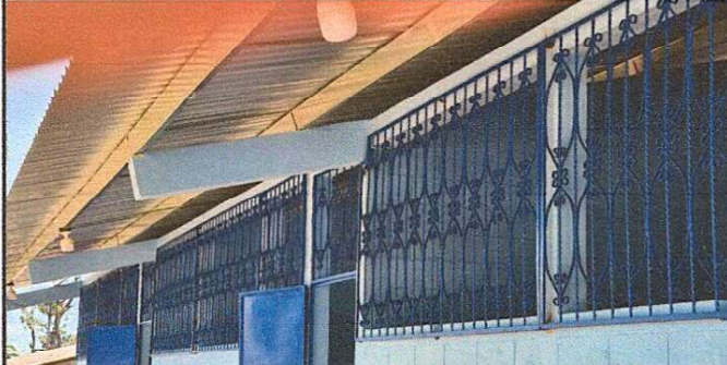
Foto 3: Después del mantenimiento y remoción de óxido, las ventanas fueron colocados nuevamente en su lugar, con pintura nueva.
