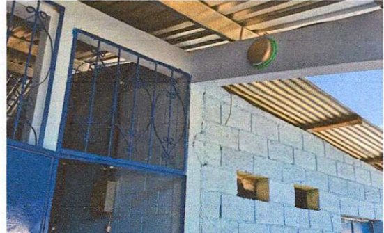
Foto 4: La línea del sistema eléctrico fue reemplazado en su totalidad con nueva instalación y nuevos accesorios, iluminando por las noches el corredor y patio del centro educativo.
